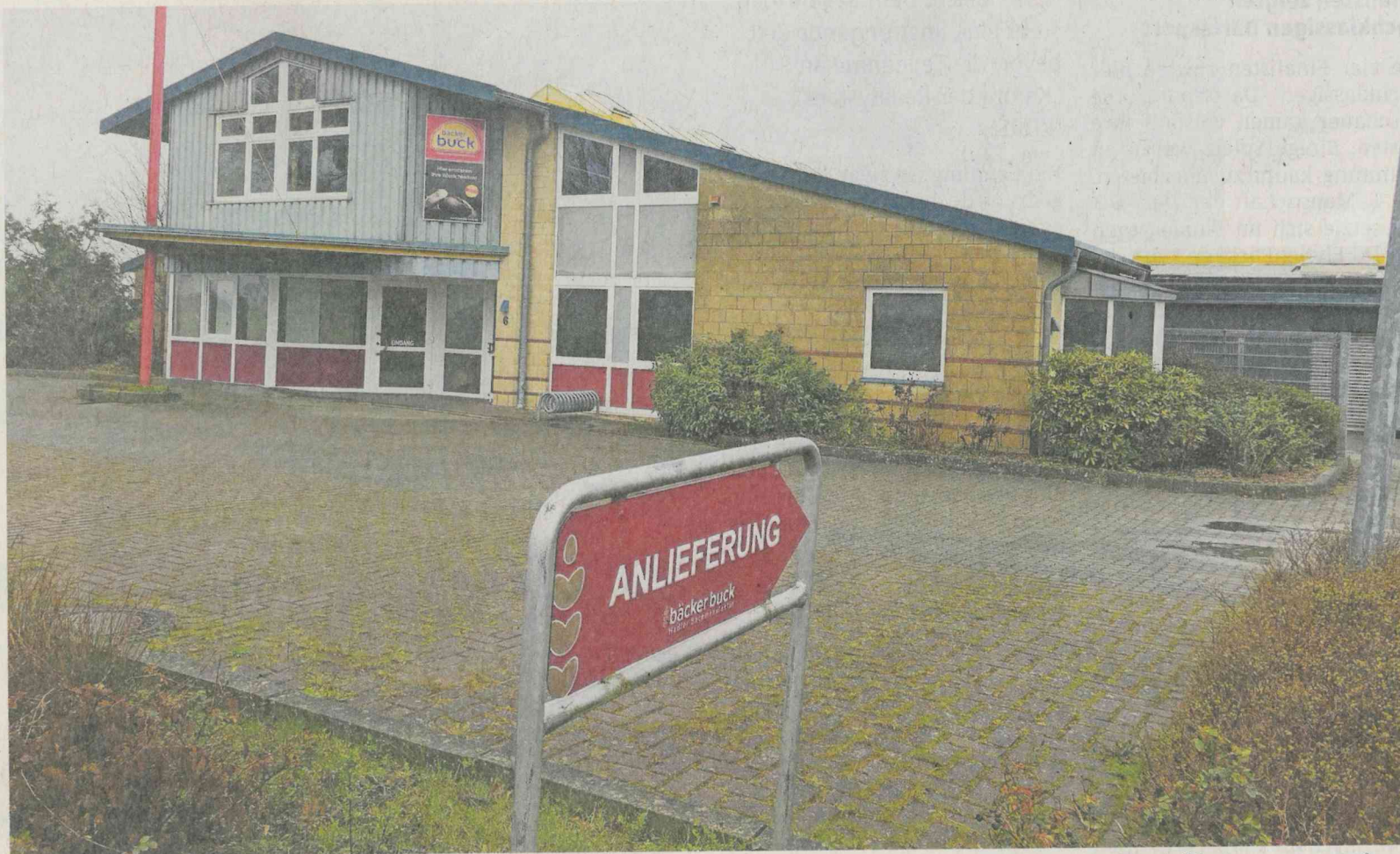
Im Cadenberger Gewerbegebiet sind die Backstuben des Unternehmens untergebracht. Die sechs Filialen von Cuxhaven bis Hemmoor werden von hier aus versorgt. Fotos: Kramp
